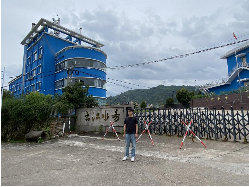
文成县新水厂（主管工程终点）
